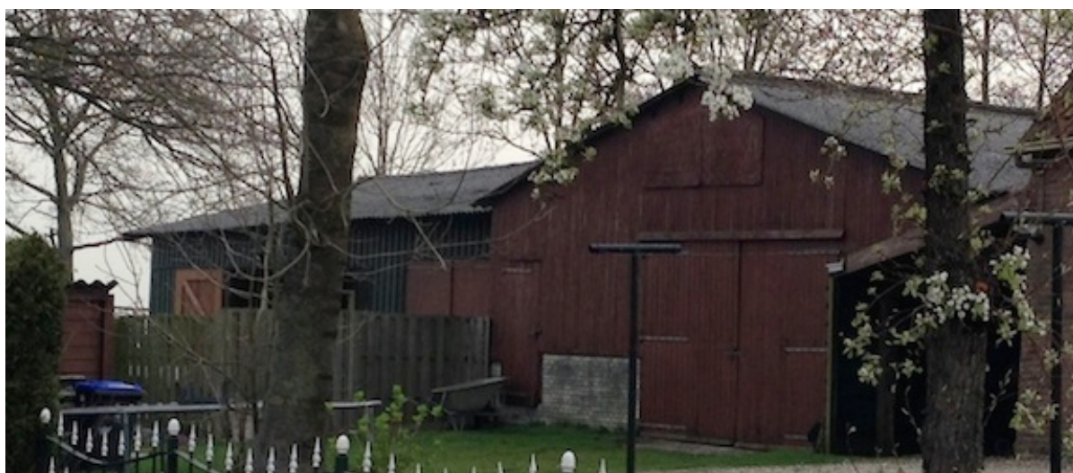
afb. 4 bestaande schuren achter huisnr 22 (C,D en E)
