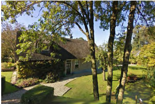
Figuur 5: Bestaande bedrijfswoning vanaf de Lopikerweg West
