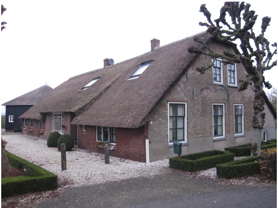
Voor- en linker zijgevel woning
