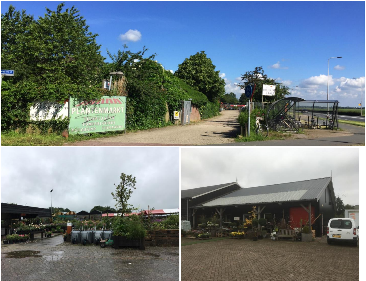
Figuur: Bestaande bebouwing (Bron: Verstoep Bouwkundigen)
