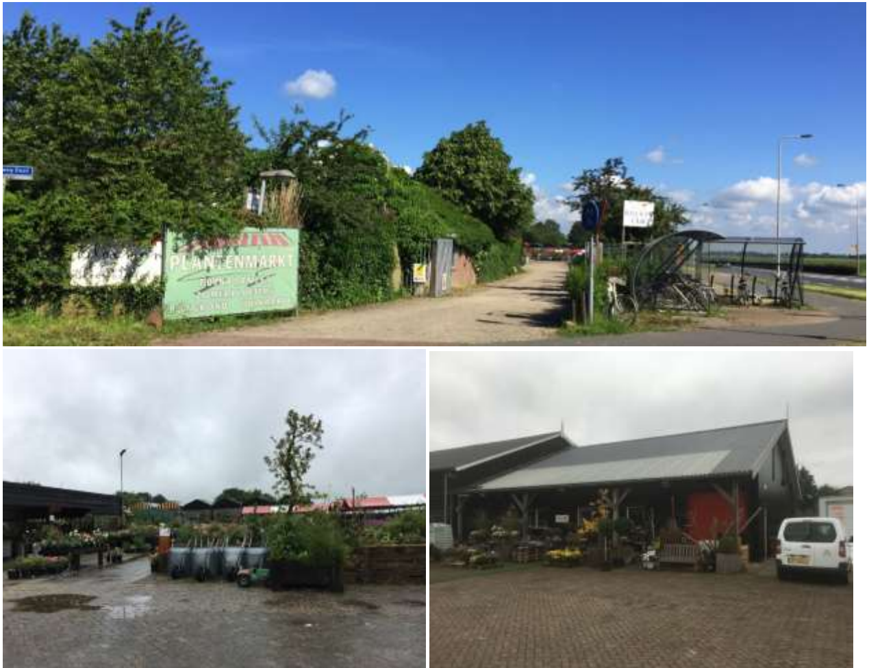
Figuur: Bestaande bebouwing (Bron: Verstoep Bouwkundigen)
