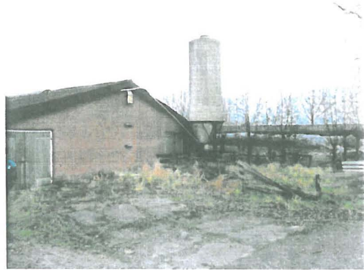
de ligboxenstal dicht op de weg
