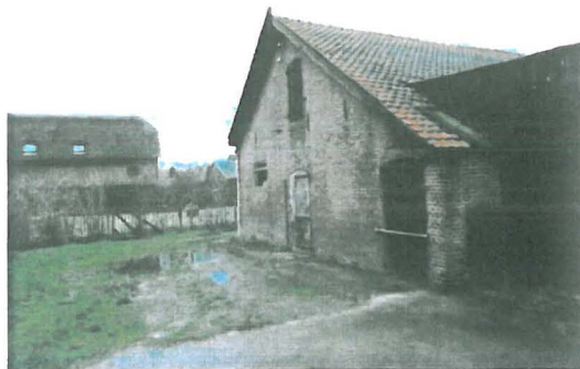
karakteristieke schuur op voormalige achtererf
