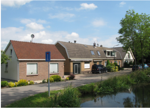
Huidige bebouwing Zuidzijdsesweg 233
