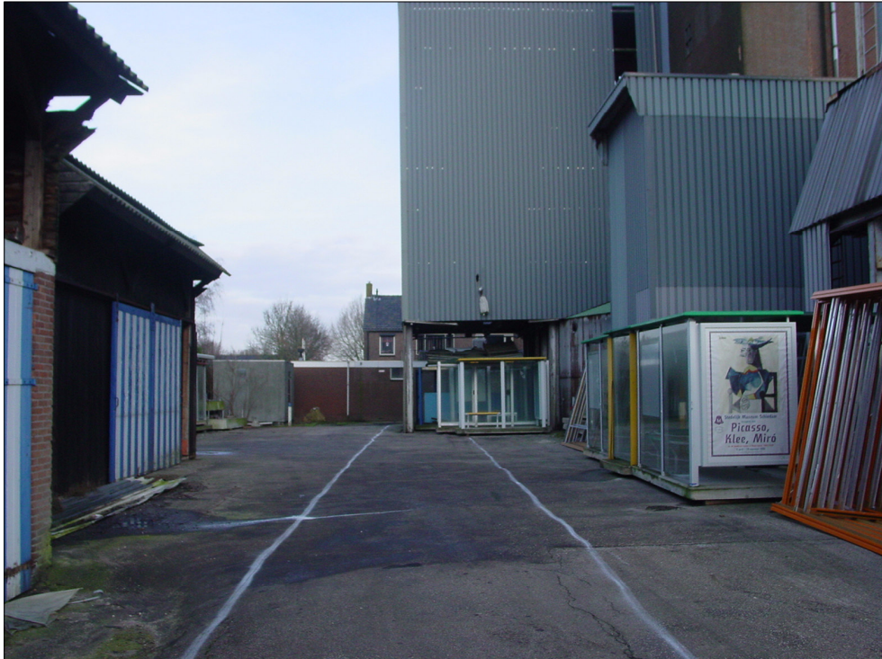
Figuur 3. Overzichtfoto van zuid naar noord van een deel van het plangebied, waarbij de ligging van proefsleuf 2 op het beton is aangegeven.
