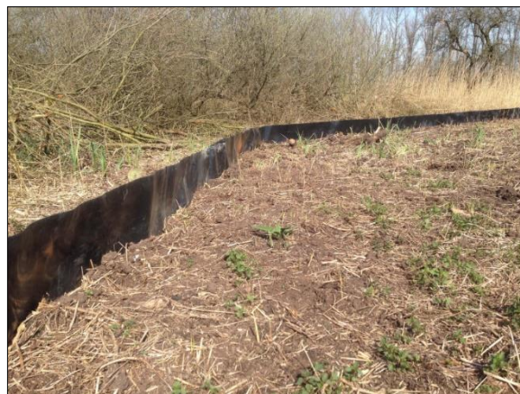
Figuur 3.1 Amfibieënscherm (bron: Faunaconstruct).
