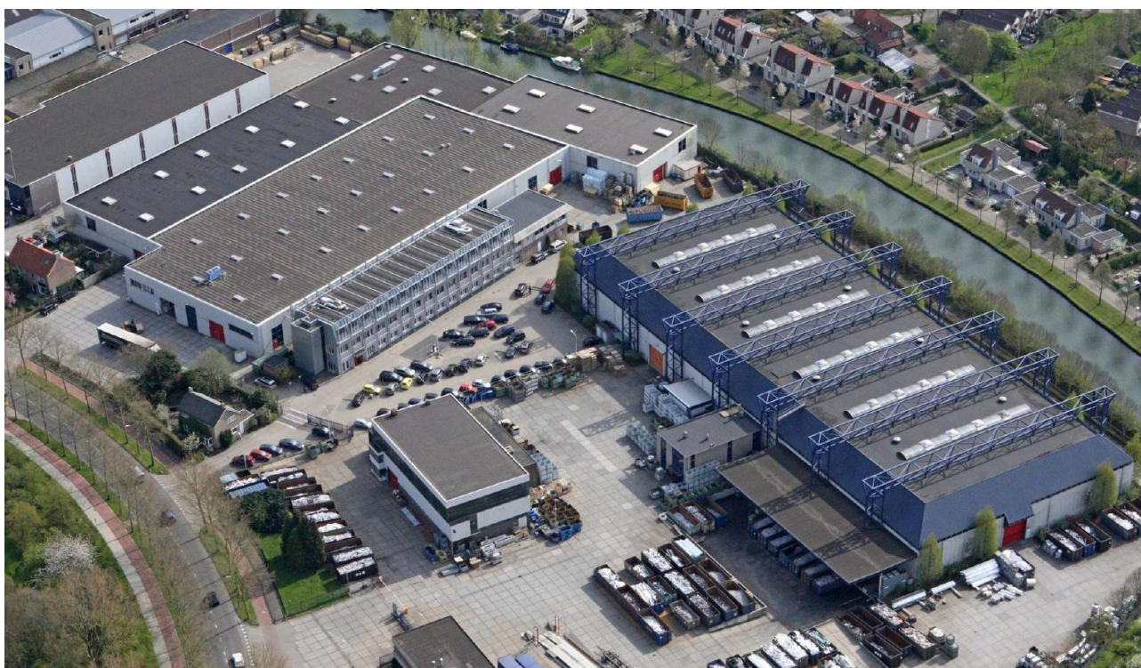
Figuur 2.1: Luchtfoto Roba Metals in huidige situatie in IJsselstein
