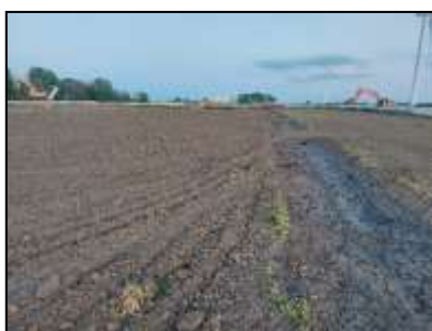
Figuur 4. Graafwerkzaamheden op de onderzoekslocatie en metalen omheining.
