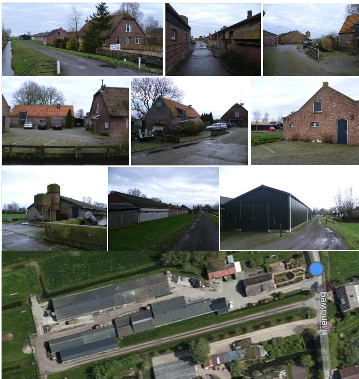
Figuur: impressie bestaande situatie Tiendweg 22/24 (Bron: Verstoep Bouwkundigen / Bing Maps)
