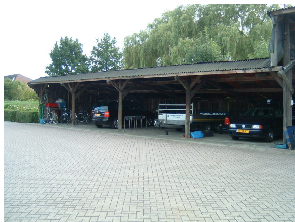
Foto 3: loods / kapschuur (zuidelijk gedeelte)
