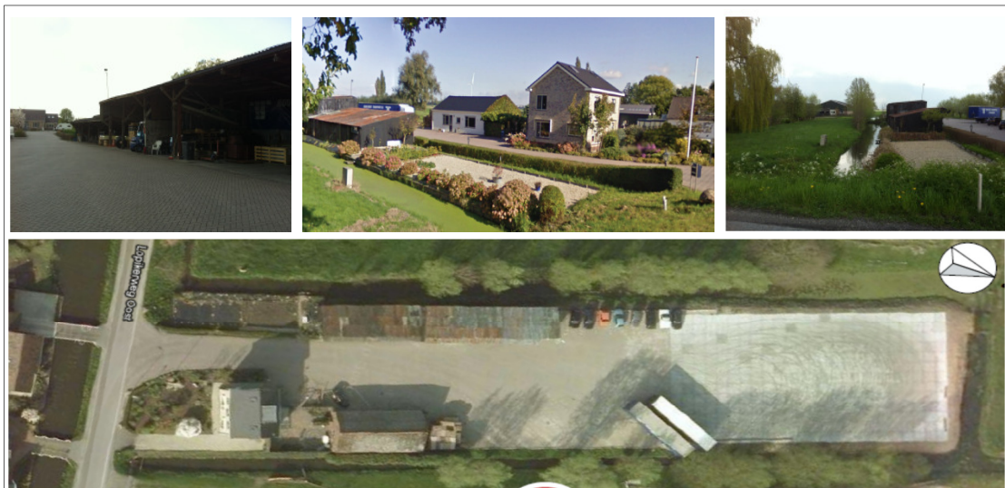
Figuur: bestaande situatie transportbedrijf Lopikerweg Oost 17a (Bron: Verstoep Bouwkundigen en Google Earth)
