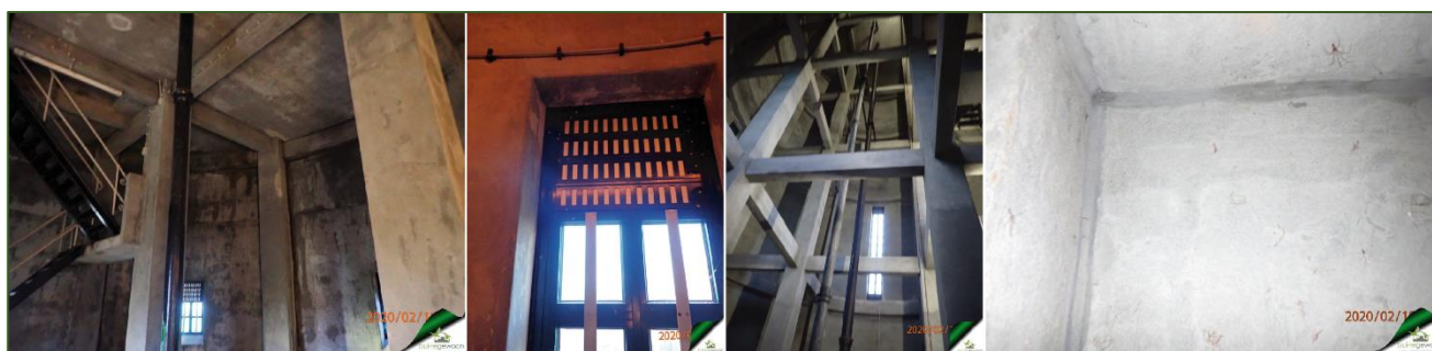
Figuur 7. Fotoregistratie binnenzijde watertoren
