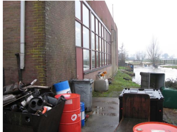
De achterzijde van het bedrijf.
