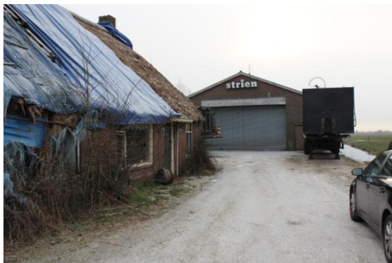
Debedrijfshal gezien vanaf de Zuidzijdseweg.
