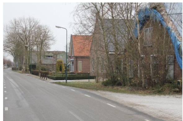
Links aangrenzende woningen. Rechts de bestaande te vervangen woning.
