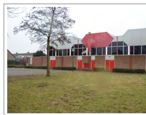
Foto 6: zuidwestelijk gedeelte onderzoeklocatie
