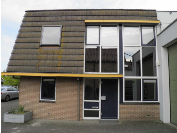
Figuur 4. Het dak loopt door tot circa twee meter hoogte.
