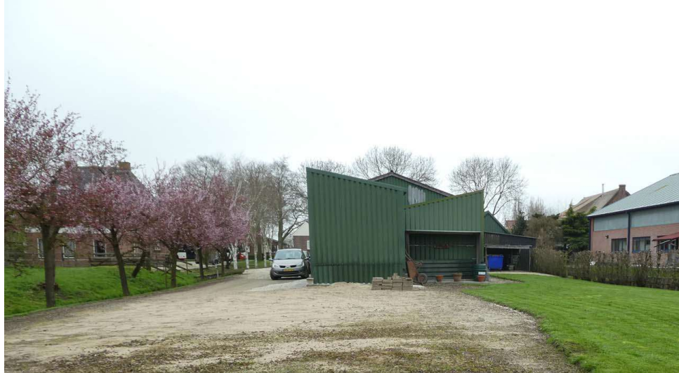
Figuur 4: Vrijstaande schuur, 'voor'-deel heeft een golfplaten dakbedekking
