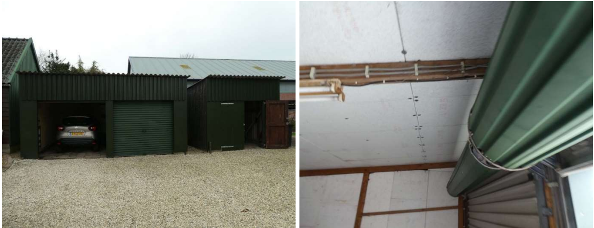
Figuur 2: Twee losstaande schuren met tempex isolatie aan de binnenzijde
