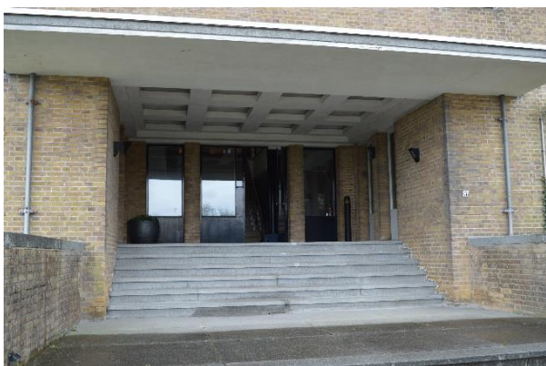
Links: de entreeportiek van het voorgebouw. De royale buitentrap met tussenbordes is uitgevoerd in kunstgraniet (beton). Het cassettenplafond en de luifel zijn uitgevoerd in beton, voorzien van cement-schuurwerk.
