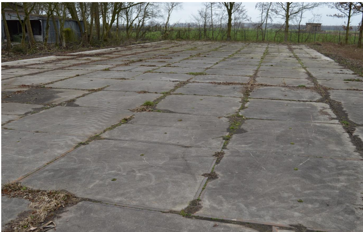
Het opslagterrein, bestraat met stelconplaten.
