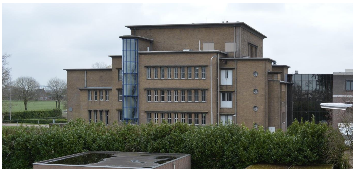
De rechterzijgevel van het hoofdgebouw, gezien van de aarden heuvel op de bunker. Rechts is nog net de aansluiting van de nieuwbouw uit 1992-1994 te zien.
