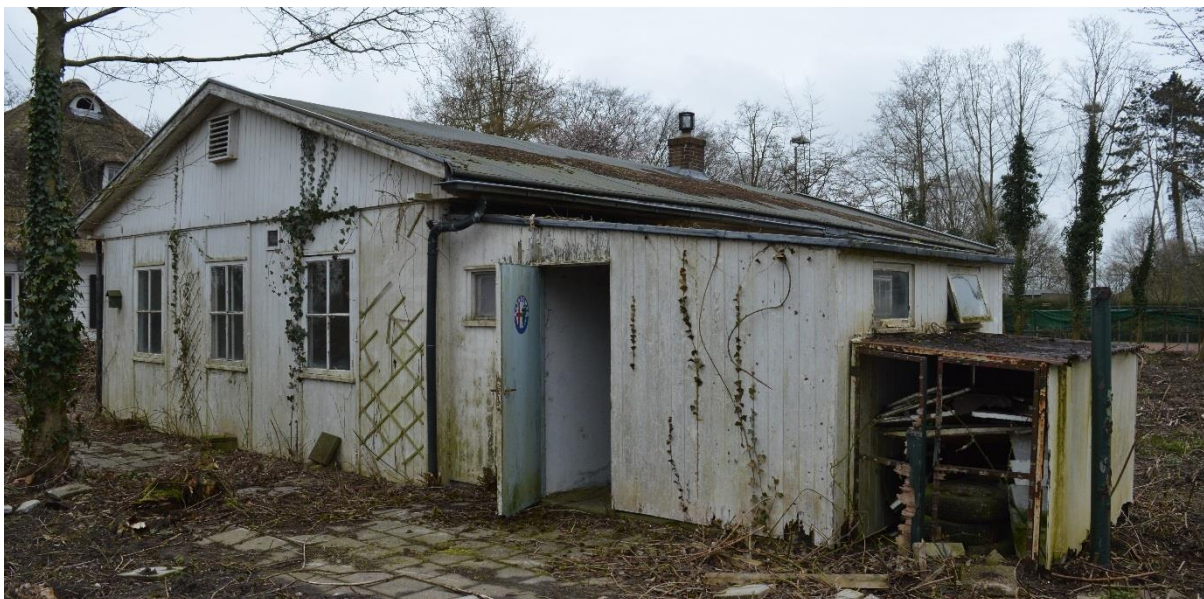
De secundaire aanbouwen tegen de noordgevel.
