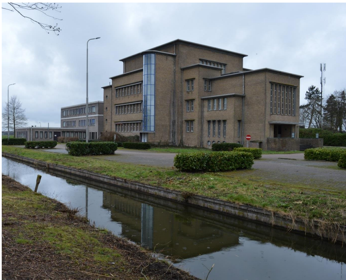
De linkerzijgevel van het hoofdgebouw. Op de voorgrond is een brede zijslot van het terrein zichtbaar, haaks op de polderverkaveling. Deze sloot fungeerde als berging voor koelwater.
