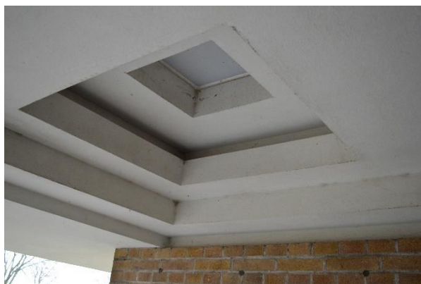
Links: de entreeportiek van het voorgebouw. De royale buitentrap met tussenbordes is uitgevoerd in kunstgraniet (beton). Het cassettenplafond en de luifel zijn uitgevoerd in beton, voorzien van cement-schuurwerk.
