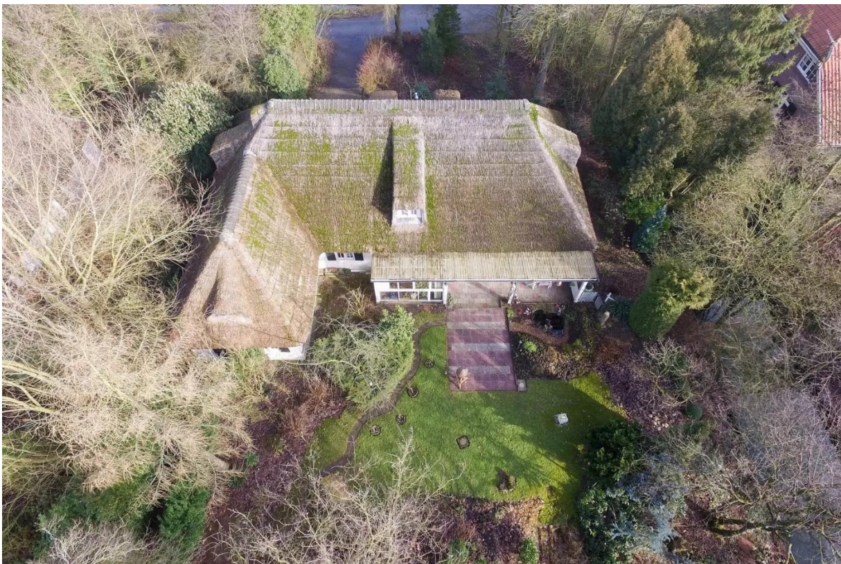
Luchtfoto van het Gemeenschapshaus ( www.redres.nl , nr. 61102130).
