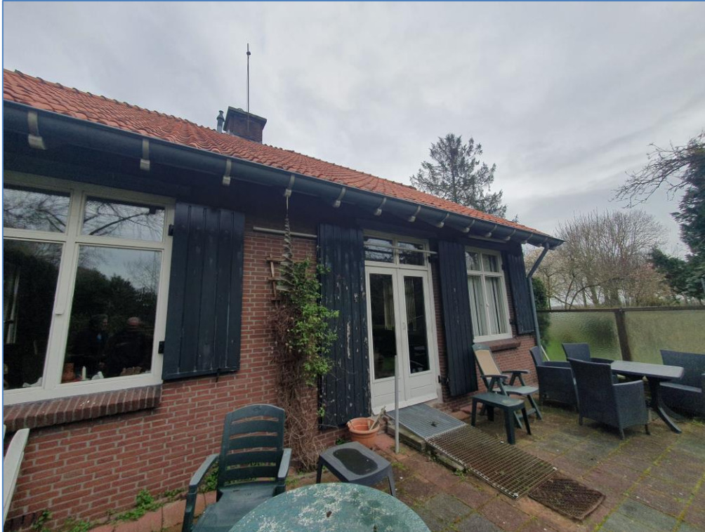
Figuur 20: Gesloten dakvlak opstal E
