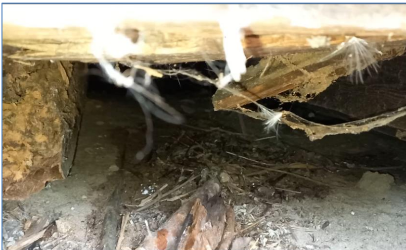
Figuur 13: Opname onder de fundering
