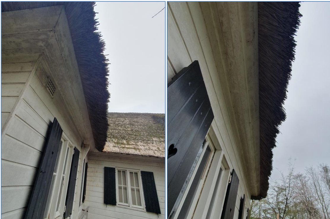
Figuur 17: De dakranden rondom zijn gesloten
