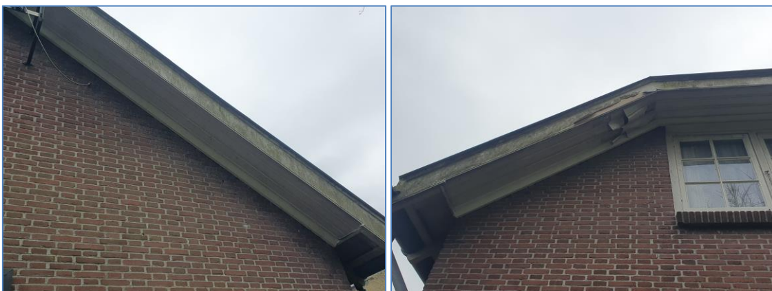
Figuur 21: Ruimte tussen het hout en de muur geeft toegang tot het overstek
