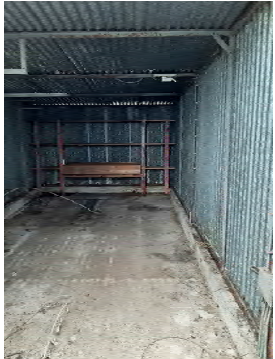
Foto 19: garagebox metaal (met verwarming)
