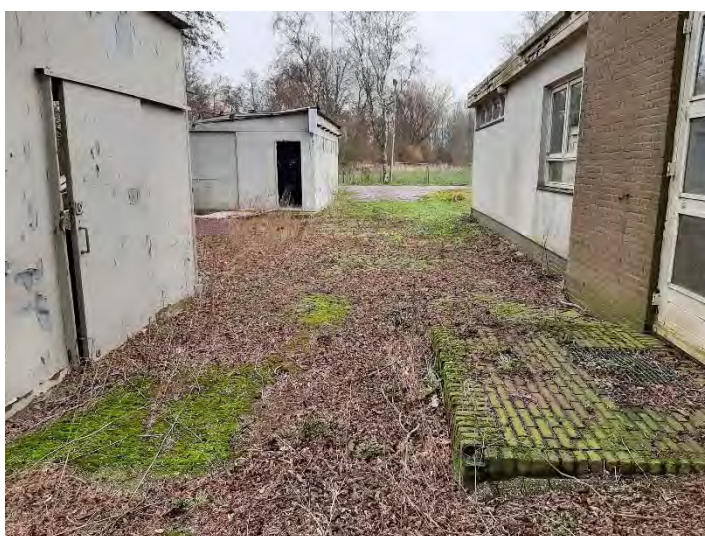
Foto 6: terrein tussen werkplaatsen en spuiterij
