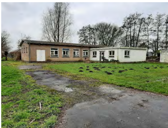
Foto 3: werkplaatsen en spuitrij
