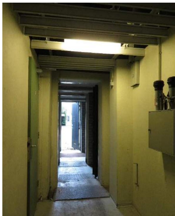
De hoofdtoegang aan de zuidoostzijde van de bunker, gezien vanaf de buitenzijde (links) en binnenzijde (rechts). Dit is een smalle gang met stalen deuren aan voor- en achterzijde. Direct achter de voorste deur bevindt zich een betonnen schuifdeur, die over rails loopt. Deze rails is afgedekt door een stalen plaat. De waarschuwing op de deur ('vloer achter deze deur is verwijderd') verwijst naar deze sleuf met rails voor de schuifdeur.
