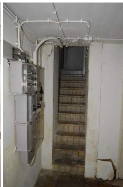
Links: overzicht van de dienstgang tussen het (voorste) trappenhuis en het lifthuis. De vloer is betegeld, de wanden en plafond zijn uitgevoerd in cementschuurwerk.
