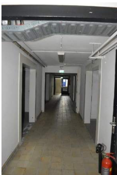
Links: overzicht van de dienstgang tussen het (voorste) trappenhuis en het lifthuis. De vloer is betegeld, de wanden en plafond zijn uitgevoerd in cementschuurwerk.
