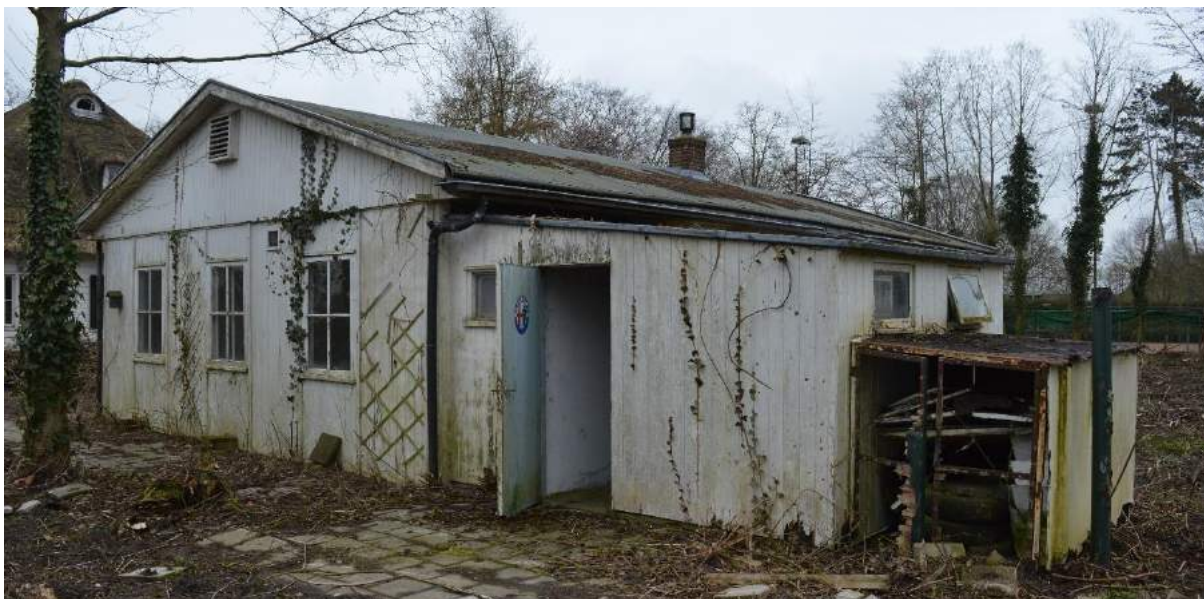
De secundaire aanbouwen tegen de noordgevel.
