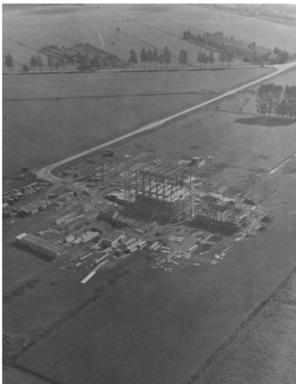
Figuur 3: bouwwerkzaamheden zendergebouw in 1939
