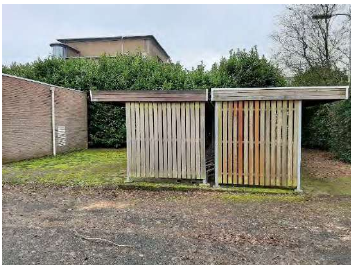
Foto 14: trafohuisje en fietsenstalling
