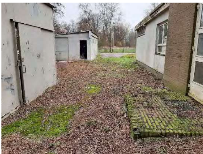
Foto 6: terrein tussen werkplaatsen en spuitery
