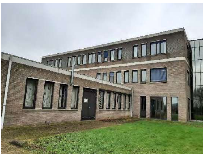
Foto 22: bedrijfspand nr. 3 (nieuwbouw jaren '90)
