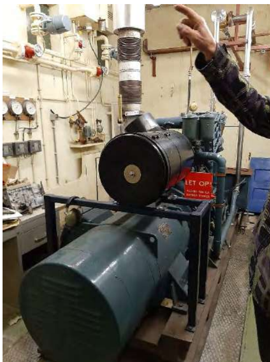
Foto 44 en 45: ruimte NSA in bunker, met oliegestookte generator
