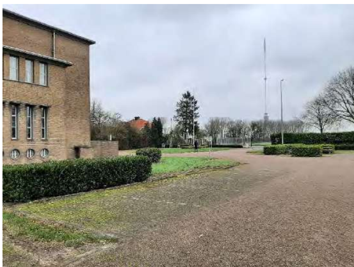
Foto 24: parkeerterrein rondom bedrijfspand
