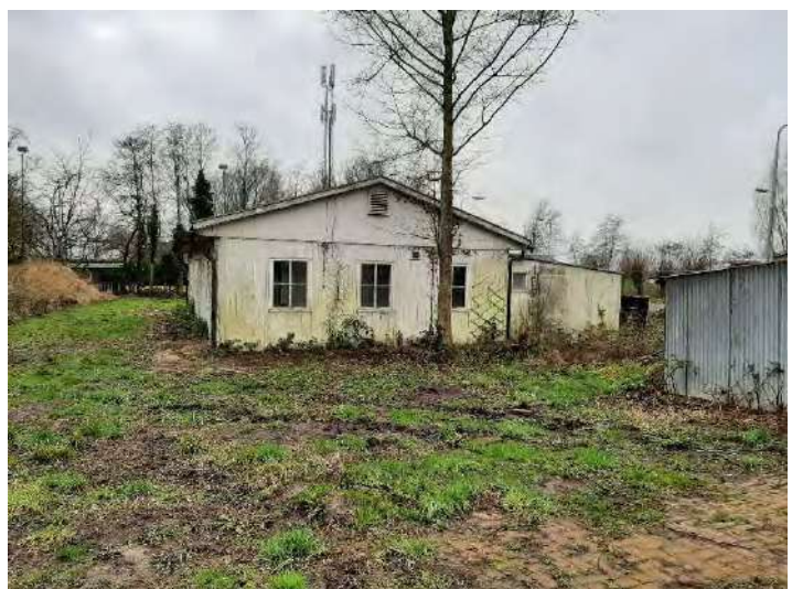
Foto 18: houten woning nr. 4C
