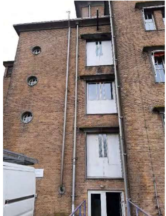
Foto's 42 en 43: ontluchting buiten het pand van de voormalige bovengrondse dieseltank in NSA
