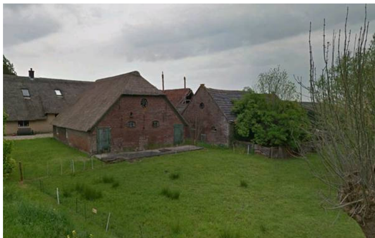
Foto 1: noordwestzijde locatie (voormalige varkensschuur en veestal)
