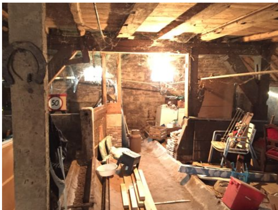
Foto's interieur schuur 1
