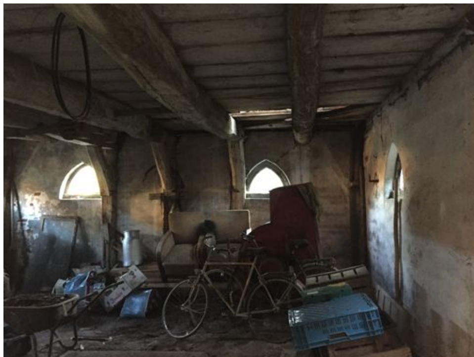
Foto's interieur schuur 2
