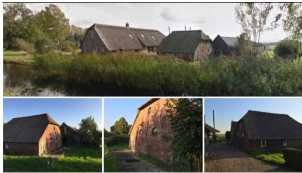
Figuur: Bestaande bebouwing (Bron: Verstoep Bouwkundigen)
