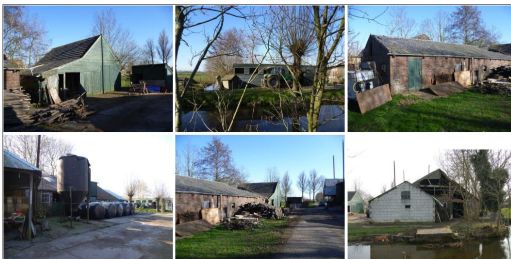
Figuur: bestaande bebouwing Noordzijdseweg 215 (Bron: Verstoep Bouwkundigen)
