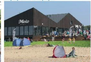
Het paviljoen wordt omgeven door een terras, met flauwe trap-treden naar het maaiveld waarop gezeten kan worden.
