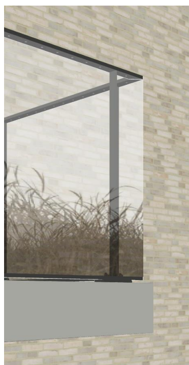
Glazen balkonhekken voorzien van folie op de onderste deel
