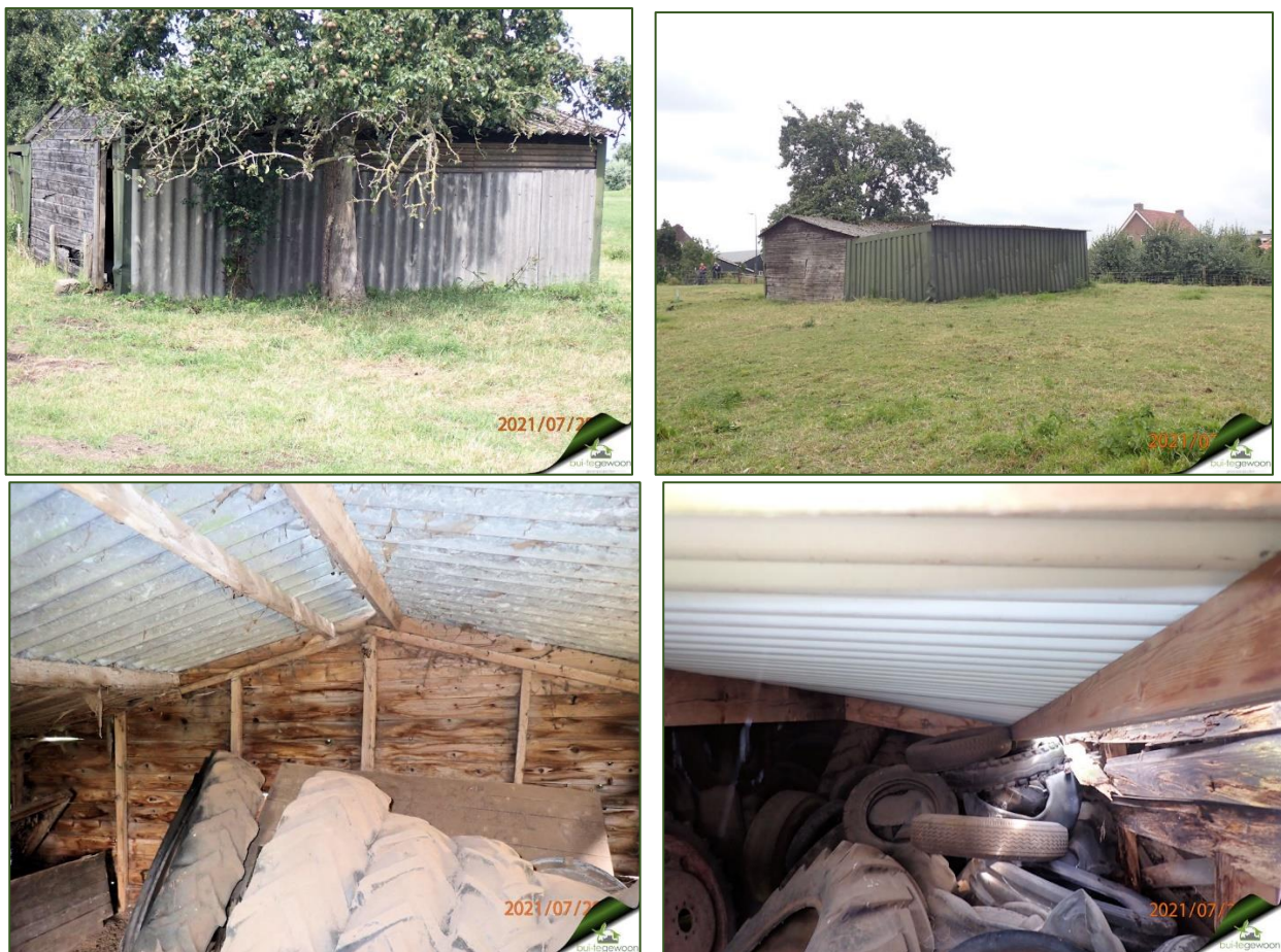
Figuur 5. Te slopen schuur
