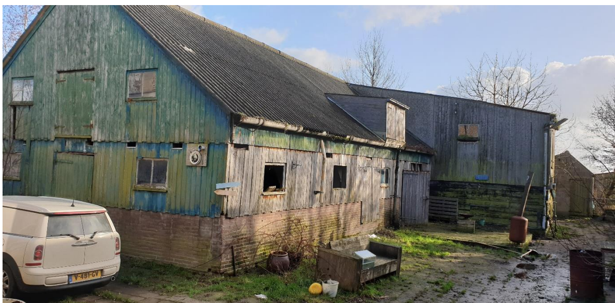
Figuur 6: foto van de gesloopte bebouwing Boveneind Zuidzijde 383
