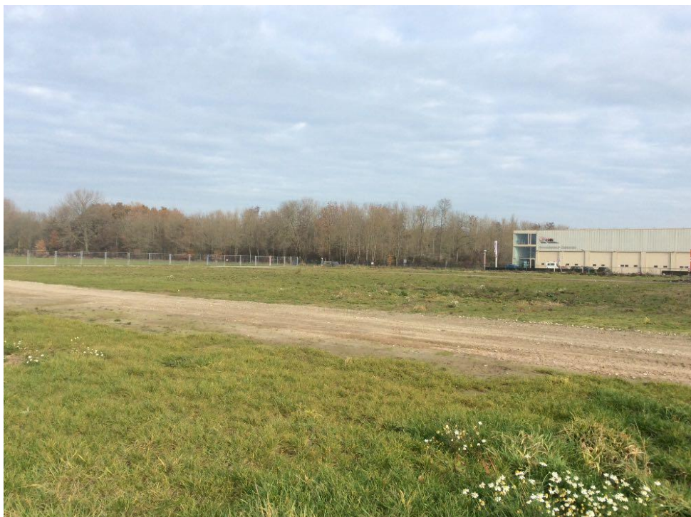
Afbeelding 2: bouwweg met gebroken puin
