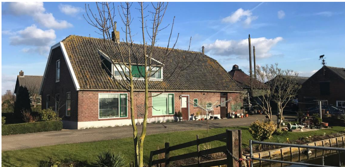
Figuur 4: Zijaanzicht (westgevel) bedrijfswoning aan de Tiendweg 5 vanaf de Tiendweg. (Bron: initiatiefnemer).
