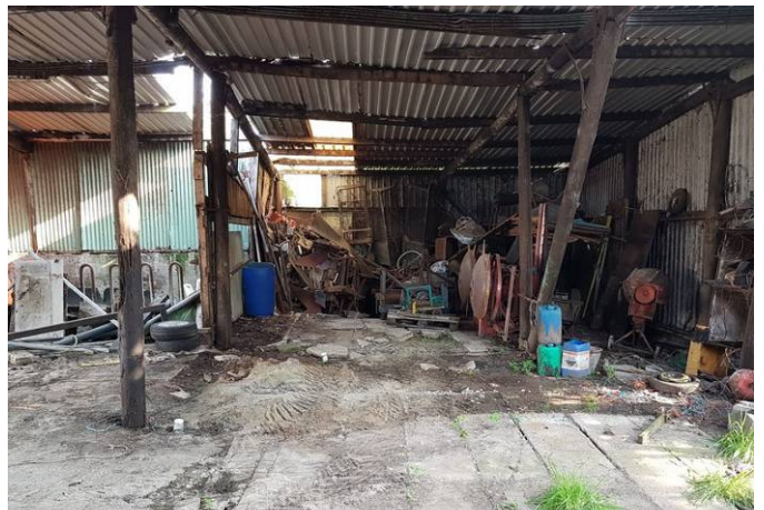
Foto 4: plaats voormalige bovengrondse dieselolietank / noordoostzijde machineberging
