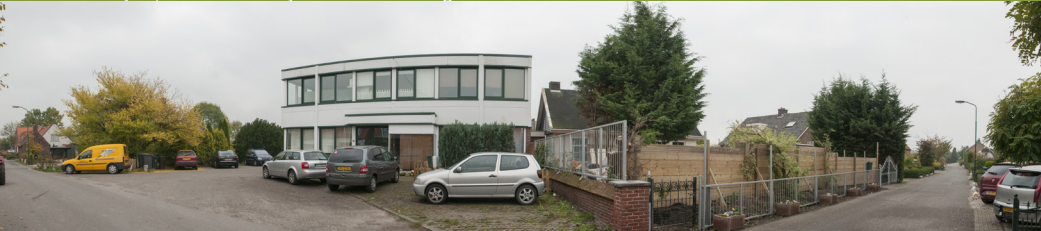
De locatie is in de jaren '70 omgevormd tot bedrijfslocatie. Deze nieuwe bebouwing sluit niet aan bij de rest van het lint.
