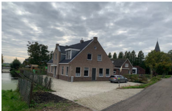
Woning Cabauwsekade 46b.
