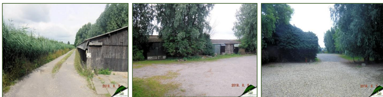
Figuur 7. Erfverhardingen (links- puingranulaat en beton, midden- beton granulaat, rechts-grind)
