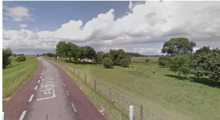
Beplanting op de steunberm
