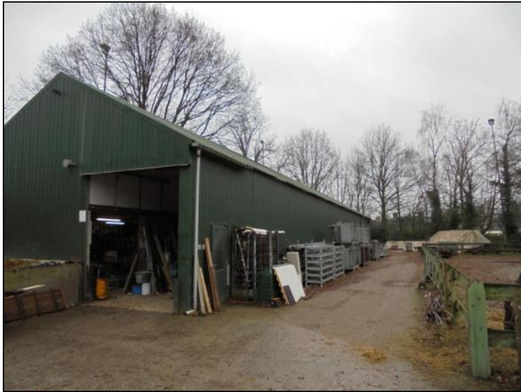
Opslagloods (richting noord-zuid)
