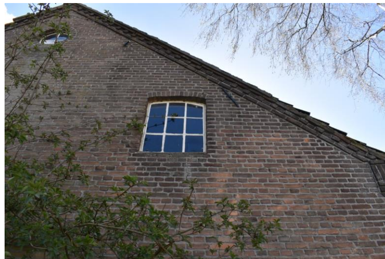
Venster verdieping linkerzijgevel.
