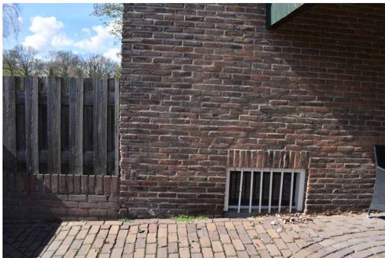
Keldervenster onder voormalige opkamer.
