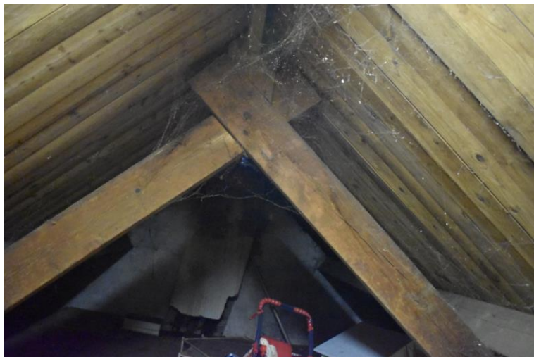
Houten constructie met boutverbinding woondeel.
