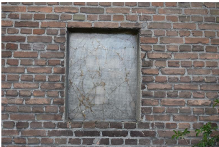
Later gerealiseerde en dichtgezette opening.
