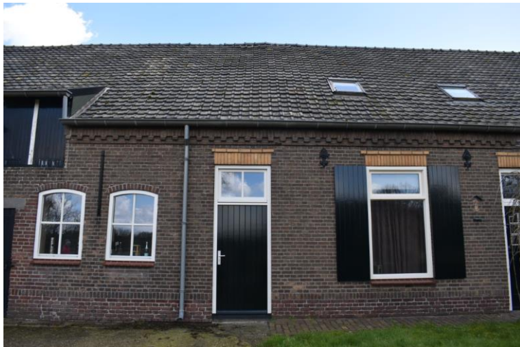
Links het bedrijfsdeel rechts het woondeel.
