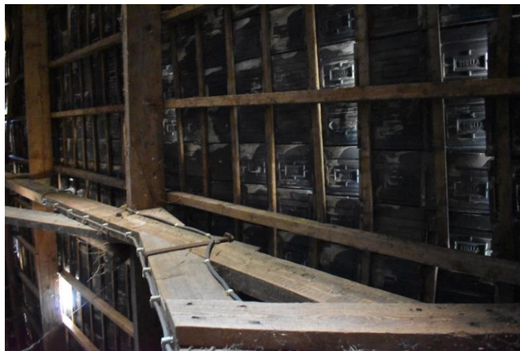
Houten constructie met moerboutverbinding.
