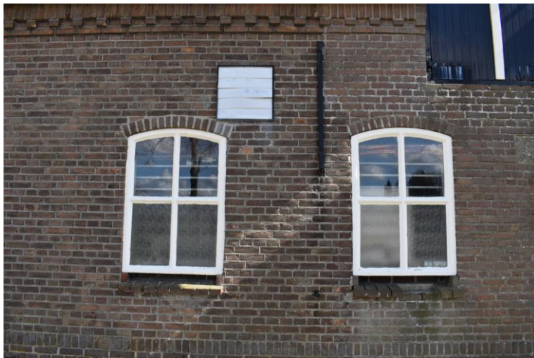
Twee betonnen vierruits vensters.
