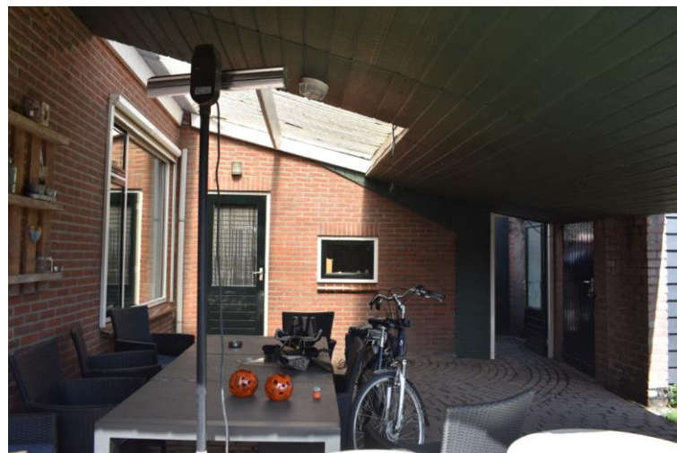
Rechterzijgevel van de aanbouw oorspronkelijk bedrijfsdeel.
