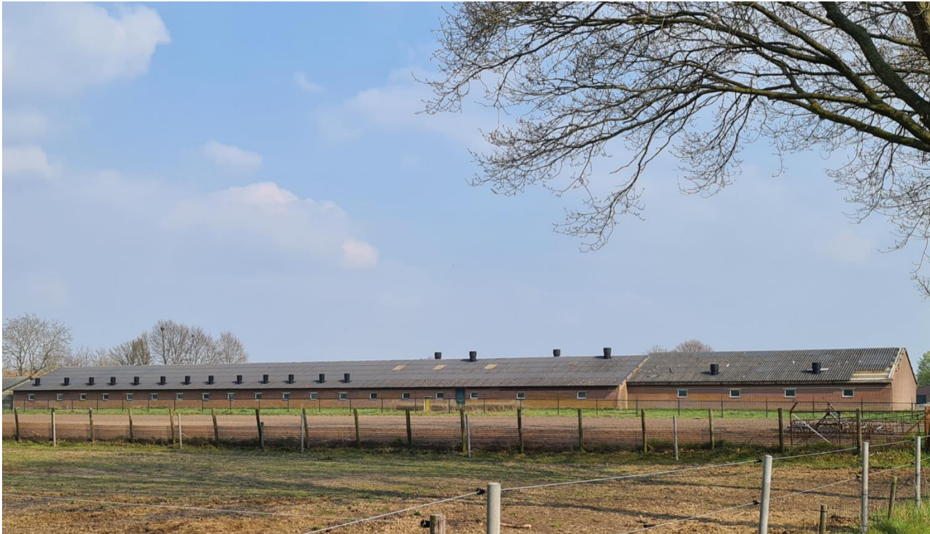
Figuur 4: Stallen gezien vanuit het westen
