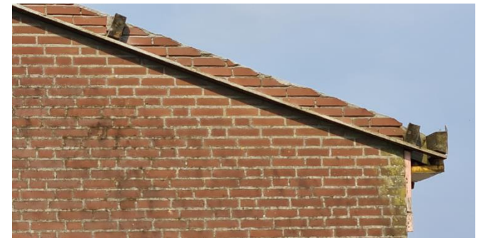
Figuur 6: Detailopname dakrand
