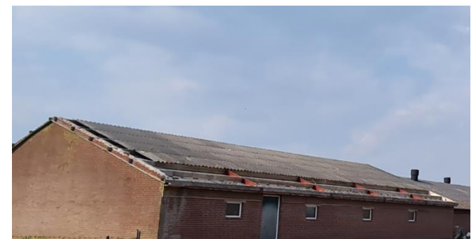
Figuur 9: Deels verwijderd dak
