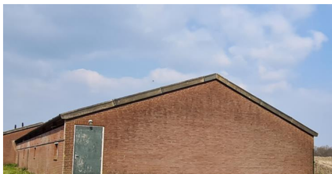
Figuur 8: Detailopname dakrand
