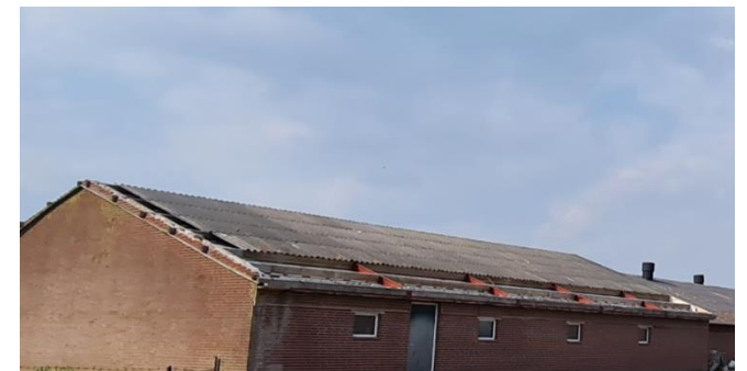
Figuur 9: Deels verwijderd dak
