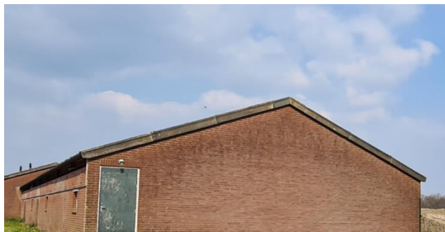
Figuur 8: Detailopname dakrand
