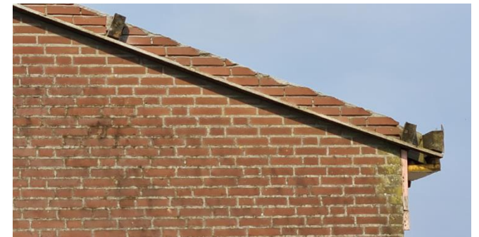
Figuur 6: Detailopname dakrand
