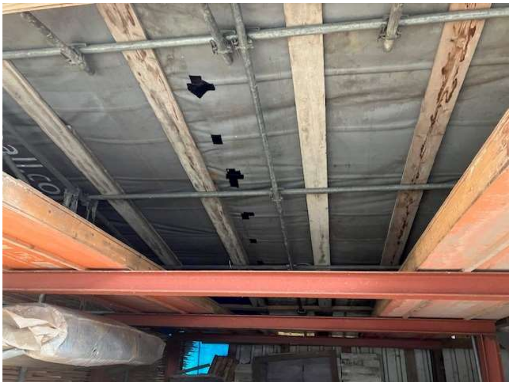
• Afbeelding 6: Dakconstructie houtopslag
