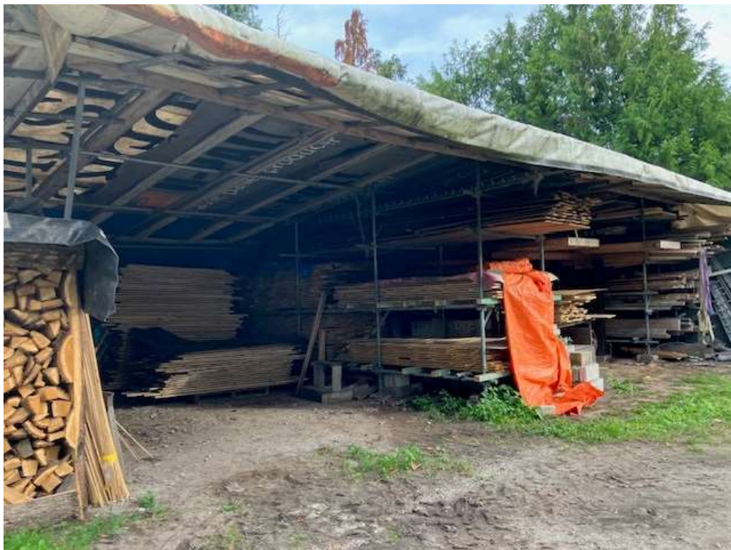
• Afbeelding 4: Tijdelijke opslag van hout tbv nieuwbouw
