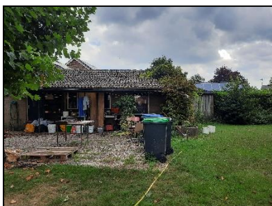
Figuur 6. Garage op onderzoekslocatie.
