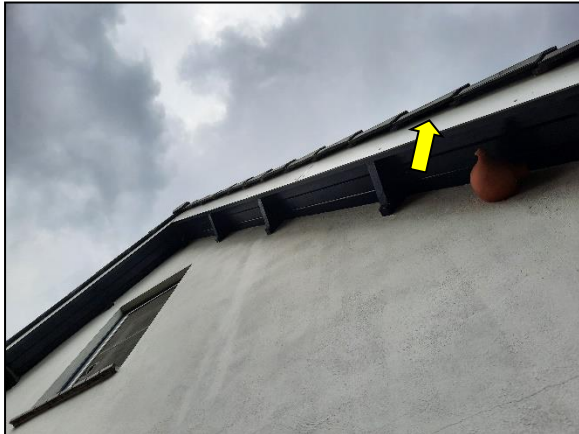
Figuur 9. Ruimte onder dakpannen.
