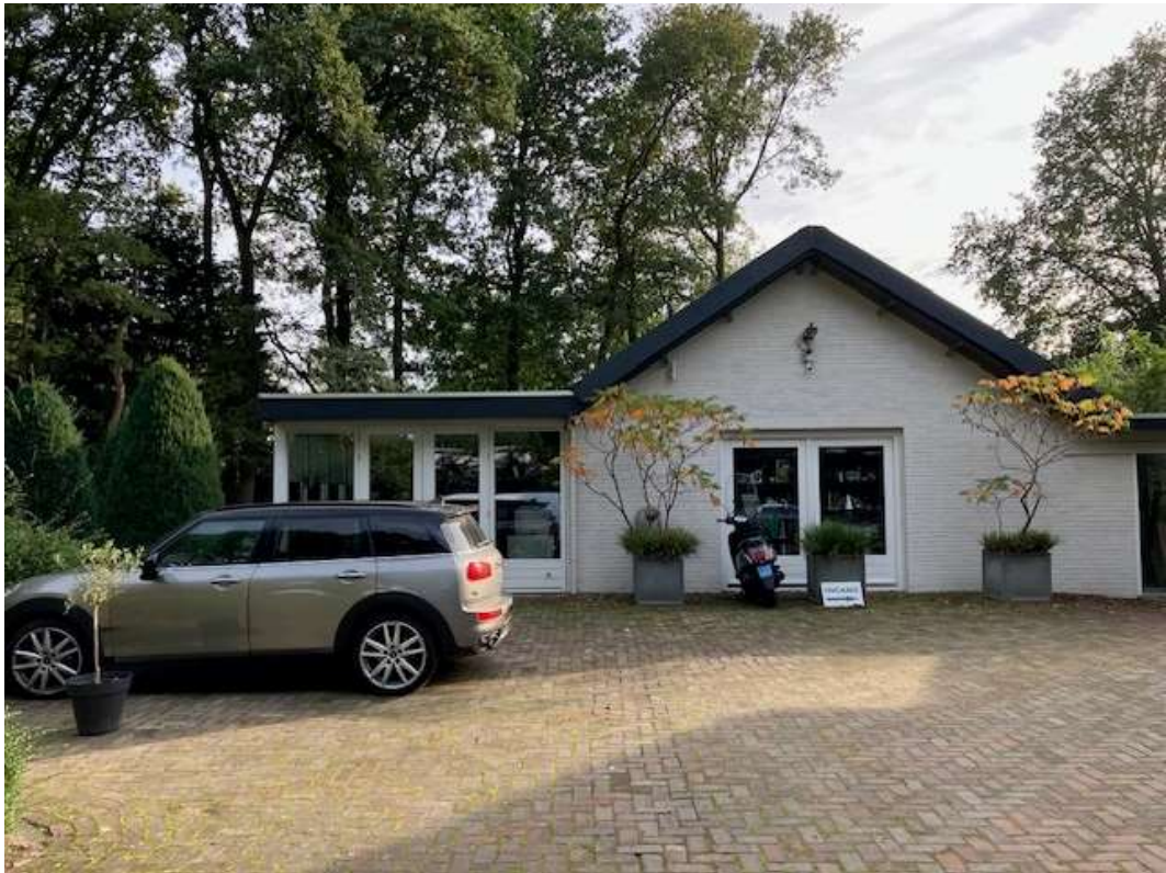
• Afbeelding 4: Bijgebouw aan de voorzijde van het perceel
