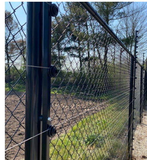
02. bestaand beveiligingsraster met bewegingsdetectie
