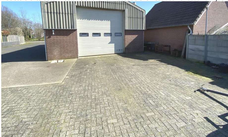
foto 5: tankplaats en ondergrondse dieseltank
